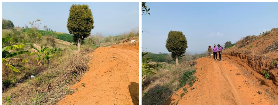
ซ่อมแซมถนนลูกรังเข้าสู่พื้นที่การเกษตร หมู่ที่ ๑-๘
