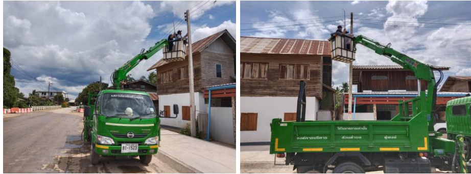
ปรับปรุงระบบประปาหมู่บ้านดอนตูพงษ์
