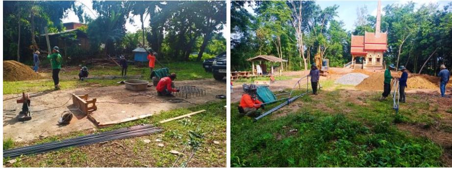
ปรับปรุง/ซ่อมแซมไฟฟ้าสาธารณะ
